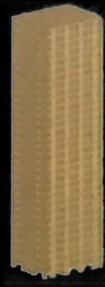
Система несущих стен CLT До 80 этажей
